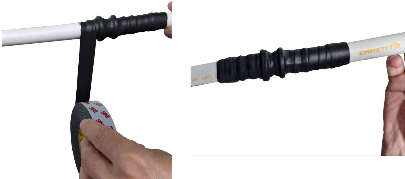
Aplicado conforme as orientações da Emmeti, o sistema protetivo têm durabilidade **de 8 a 10 anos** conforme manual do fabricante, após esse período, deve ser analisado a proteção mecânica, e se necessário, a fita deverá ser removida e o processo deve ser refeito.
